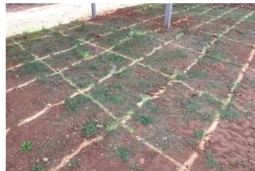
Photographie 18 – Aperçu de l'ombrage provoqué par les structures d'une centrale photovoltaïque ; notons la présence d'un développement végétal (source : BD ECO-STRATEGIE)
