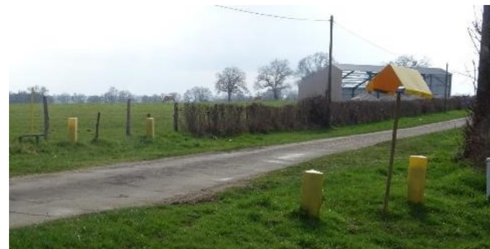
Photographie 17 – Signalisation de la canalisation de gaz au nord de la ZIP
